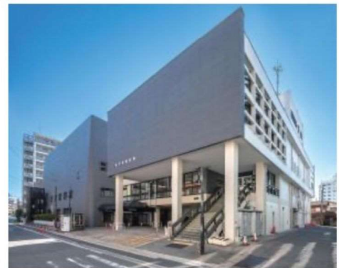
外観 正面入口
