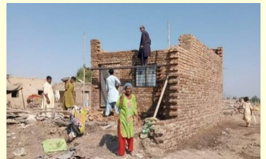
家屋の建設中
