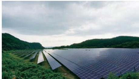
2019年2月より稼働を始めた庄内・遊佐太陽光発電所(メガソーラー)を見学しました。敷地面積は31ha。月光川沿いにあった碎石工場跡地を利用し、年間発電量は18,000MWh、約5,700世帯の平均的消費量を発電します。
