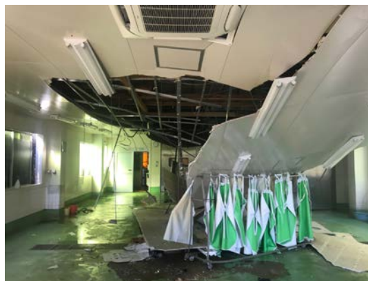
写真は、東安房漁協の千田加工場。「しめさばかぶら漬（大根使用）」（左）の加工室。上：天井が崩落。エプロンのハンガーラックが支えになり、ラックを外すと全て崩れてしまう状態。建物の屋根・窓が破壊され、天井部分に雨がたまり、重みで崩落したと思われる。下：修繕後のようす
