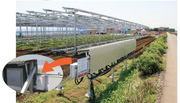
近隣が停電した場合には、停電用コンセントボックスの蓋を開けてコンセントから直接電気を使えます
